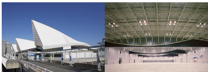
●展示面積:10,000m 2 ●天井高:最大19m ●床荷重5t/m 2
